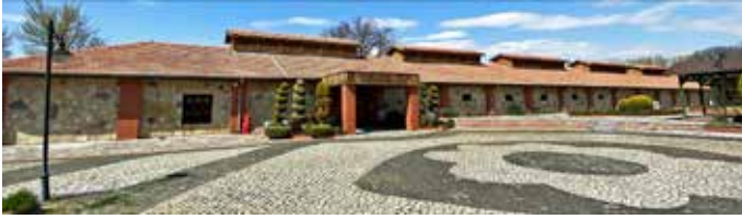
Resim 22. Müze giriş/güneydoğu cephesi
