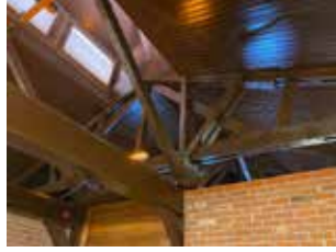
Resim 20. Fener çatı detayı
