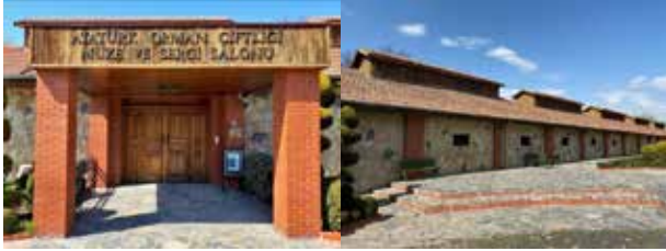
Resim 21. Müze giriş/güneydoğu cephesi
