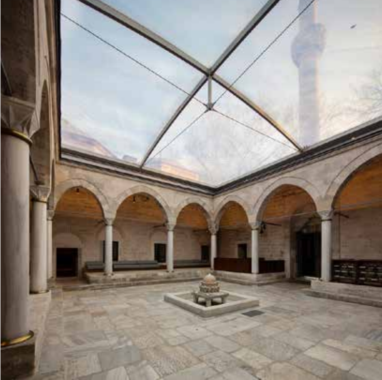
Resim 1: Beyazıt Devlet Kütüphanesi, renovasyon sonrası yazma eserler girişi avlu iç görünümü.
