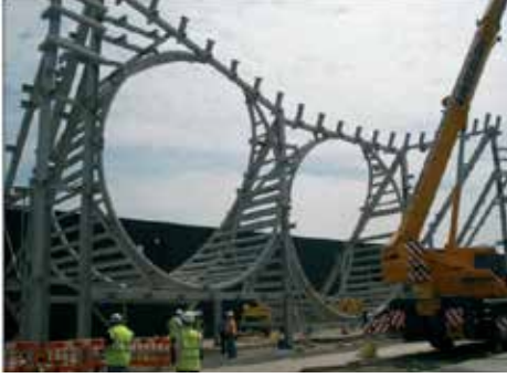
Şekil 9. Türbin çelik yapısının deneme montajı (Alexander ve Walton, 2011).
