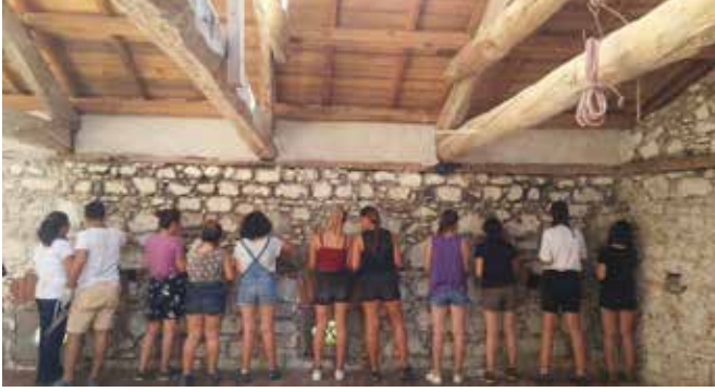
Şekil 12. 2019 Restorasyon Atölyesi - Derz Çalışması. Fotoğraf: Hande Yıldız Çekindir. (Pergamon. 2019). Yazar Arşivi, Bergama (Türkiye)
