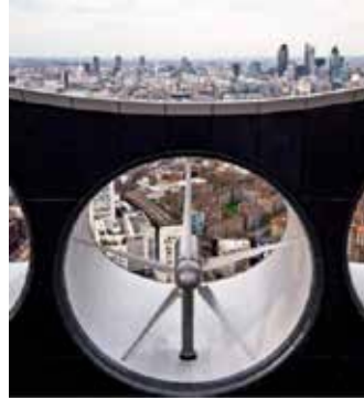
Şekil 10. Strata SE1 Kulesi'ndeki rüzgâr türbinleri için tasarlanan muhafaza bölümleri (Bogle, 2011).
