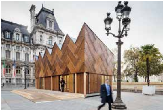
Şekil 7 Dairesel Pavyon, Encore Heureux Mimarlık Stüdyosu, Paris, 2015.
