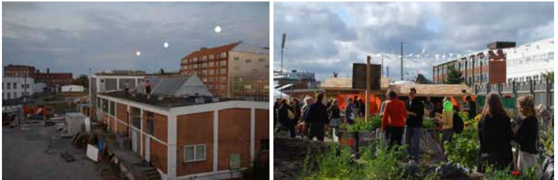
Şekil 10. PB43 fabrikasının cephe fotoğrafları (Url-19, Url-20)
